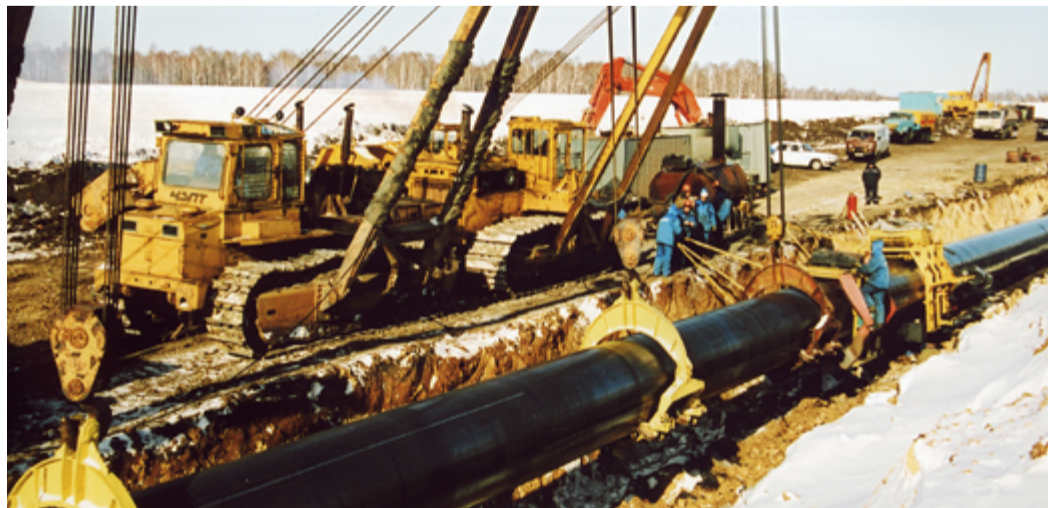
Переизоляция МГ Челябинск–Петровск Ургалинского ЛПУМГ, 2010 г.
