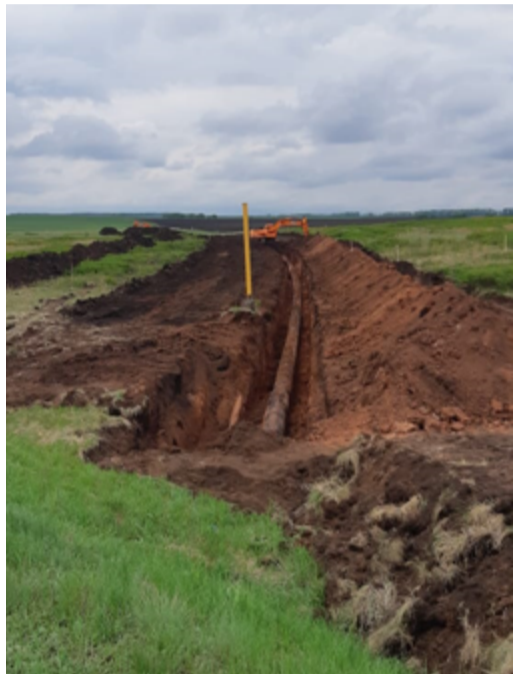
Ремонт участка МГ Шкапово–Ишимбай
