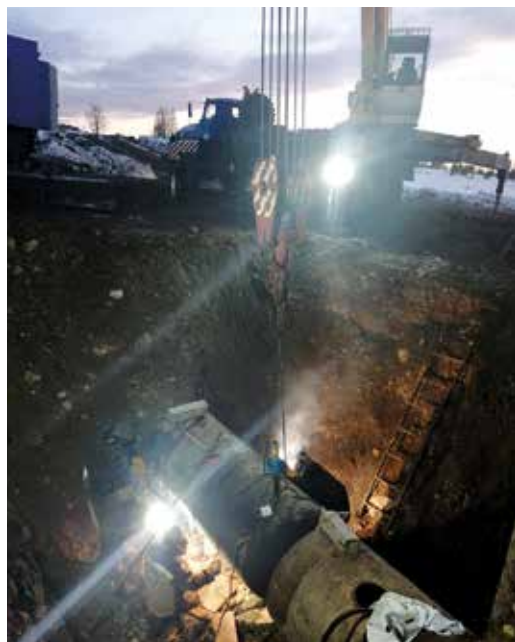
Устранение дефектов на МГ Челябинск – Петровск
