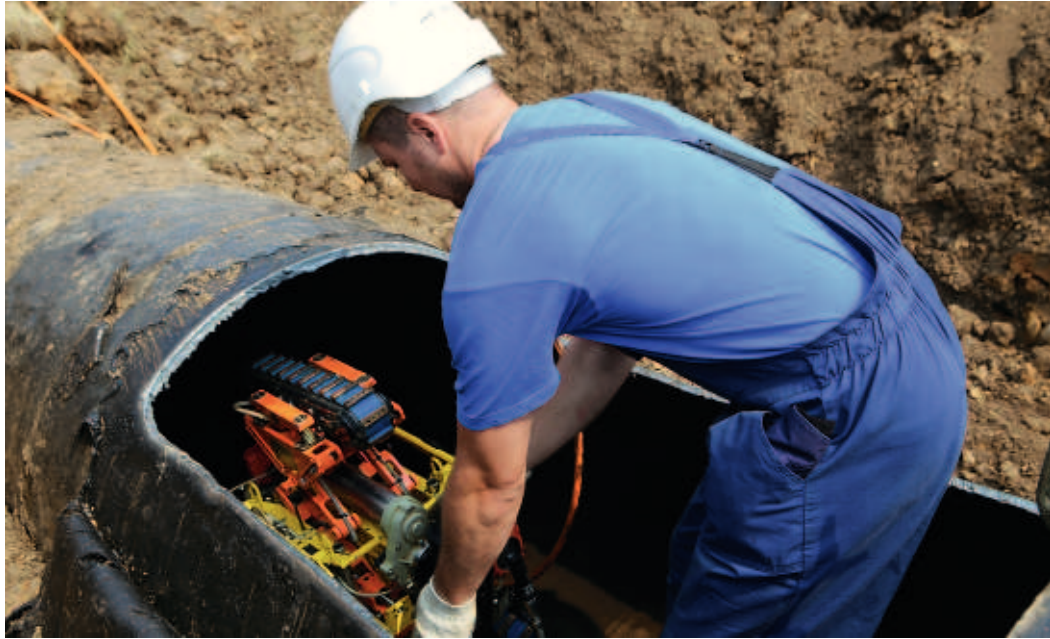
Робота погружают в трубу
