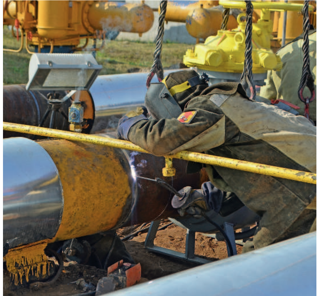
Работы на ГРС Карманово
