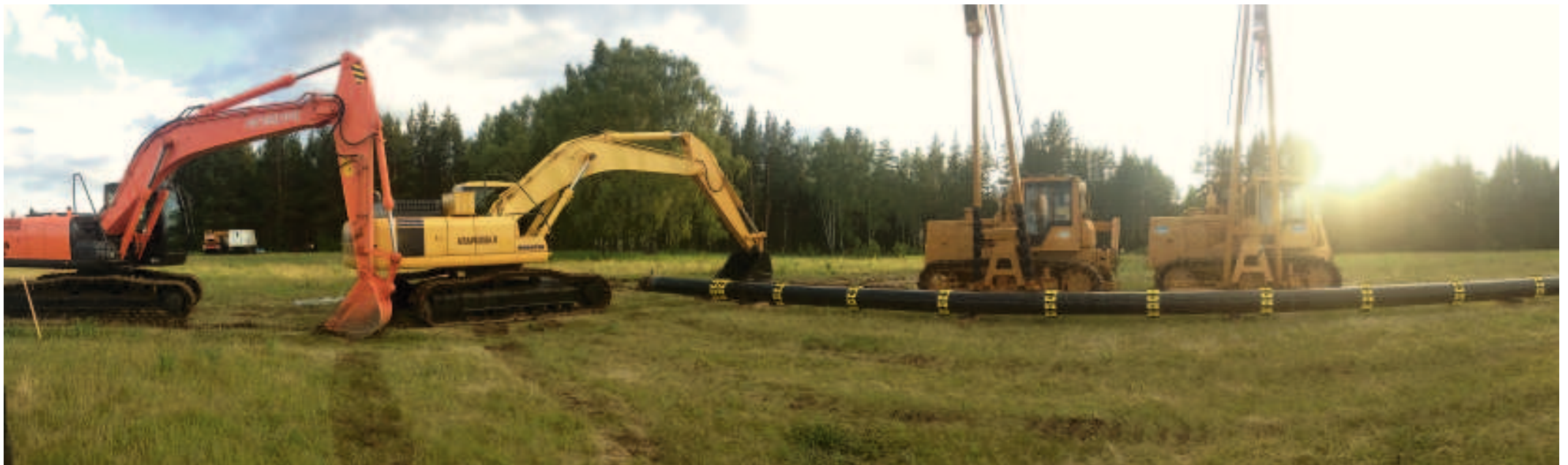
Вновь сваренный участок газопровода-отвода к ГРС Учалы подготовлен к установке на переходе через автодорогу
