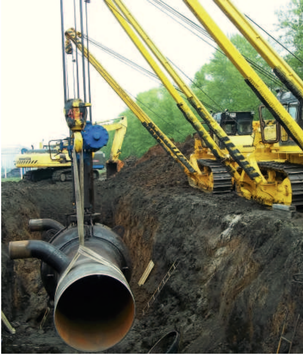
Работы на магистральном газопроводе Поляна–КСПХГ
