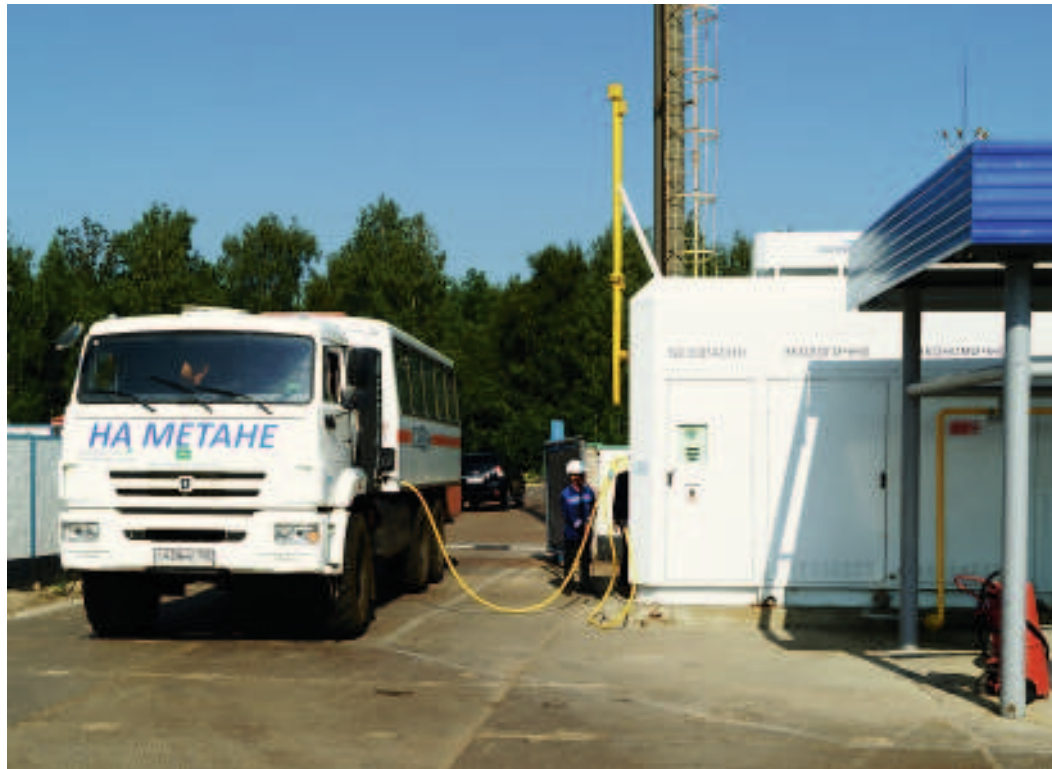
АГНКС Дюртюлинского ЛПУМГ
